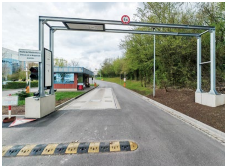
Die neue Portalmessanlage am Müllheizkraftwerk Coburg.
