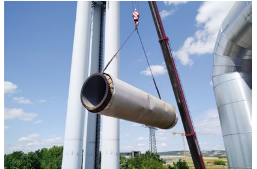
Der Korrosionsschutz an den Rauchgaskanälen wurde durch eine Fachfirma erneuert.
