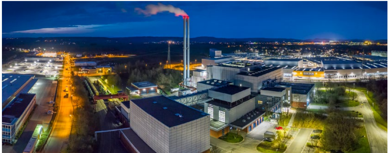
Das Müllheizkraftwerk in Coburg ist nach wie vor ein zuverlässiger Energielieferant für Strom und Fernwärme in der Region.
