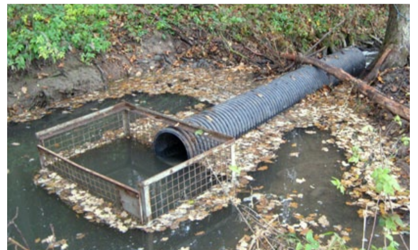
Dammdrainage an der Alster bei Lechenroth: Wasserspiegel wird auf einen für den Menschen erträglichen und den Biber ausreichenden Stand gesenkt.
