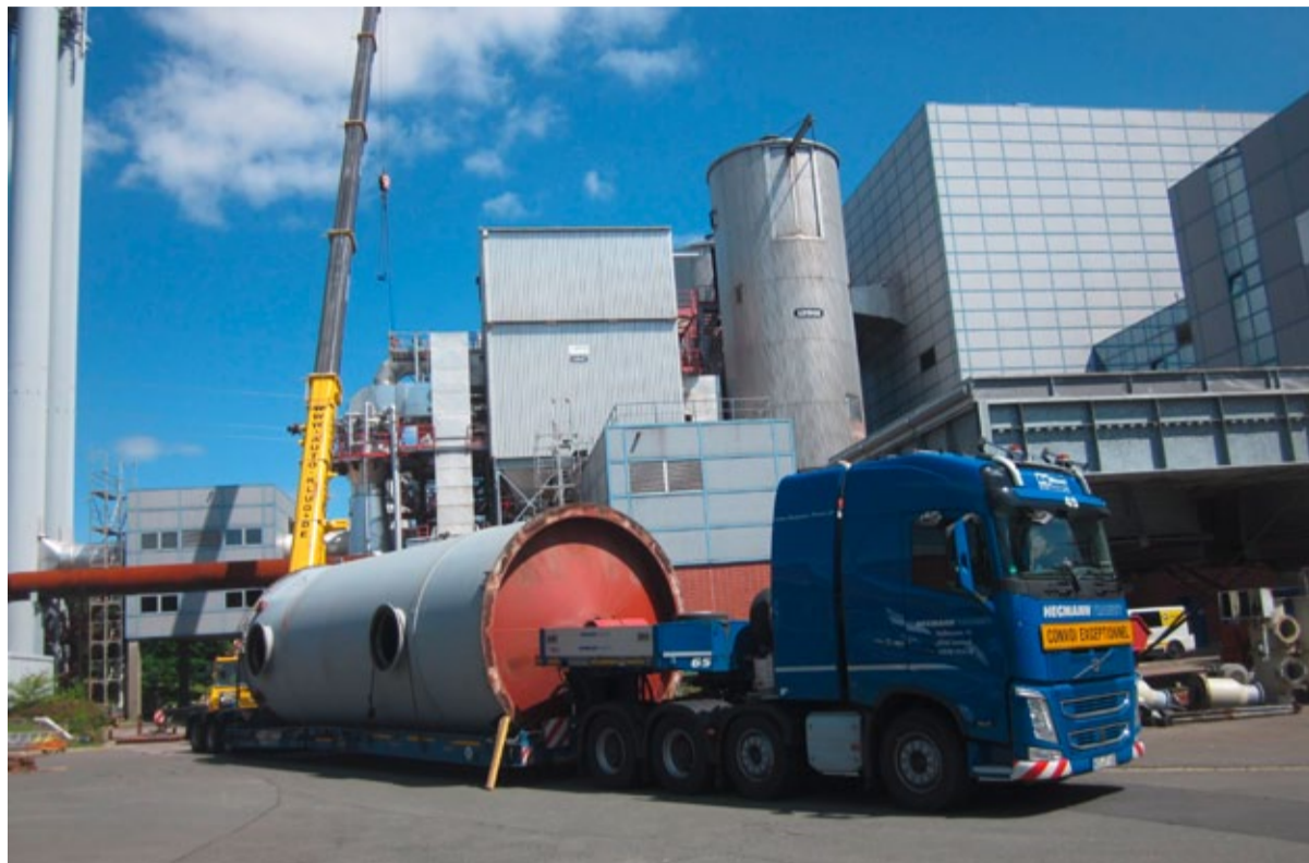
Schwerstarbeit während der Revision 2017: Der demontierte Radialstrom-Wäscher wird per Schwertransport zu einer Spezialfirma zur Aufarbeitung gebracht. Der Stahl wurde saniert und die Innenflächen neu gummiert.
