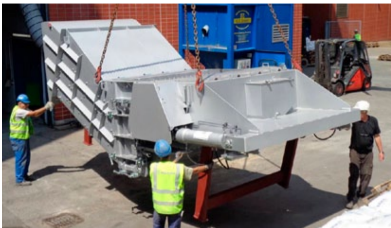
Anlieferung des neuen Entschlackers für die Mülllinie 1.
