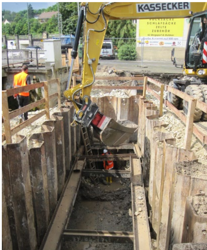
Die Fernwärmerohre werden in zwei Bauabschnitten in einem sechs Meter tiefen offenen Graben durch die Lauter verlegt.
