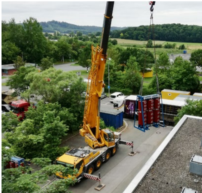
Der neue Eigenbedarfstransformator für das MHKW wird geliefert.
