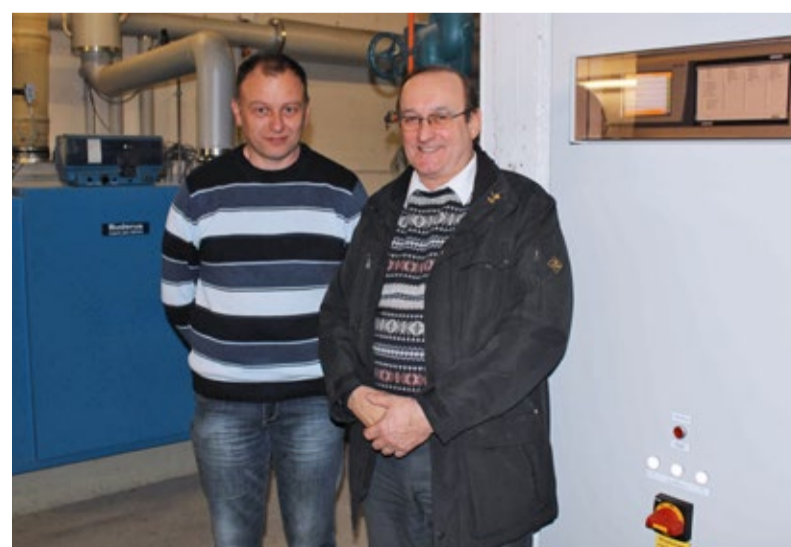
Hausmeister Willi Meinecke (links) und Harald Reibenweber im Heizungskeller der Heimatring-Schule
