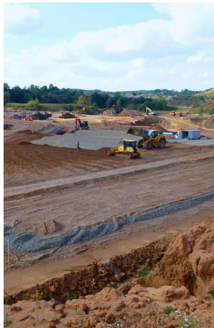
Das Deponiegelände der Fa. Schramm in Marktzeuln musste aufwendig hergerichtet werden, um die Bestimmungen der Deponieverordnung zum Grundwasserschutz einhalten zu können.
