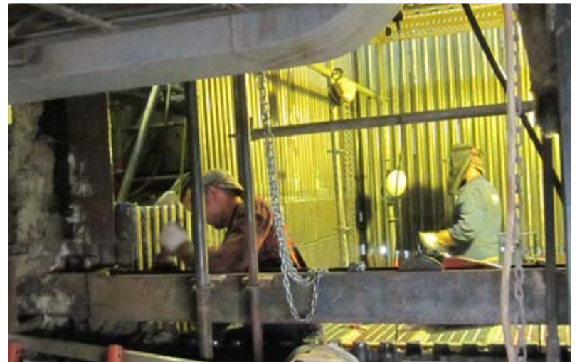
Schweißarbeiten am Müllkessel
