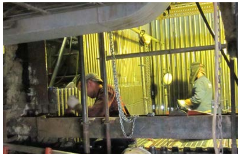
Schweißarbeiten am Müllkessel
