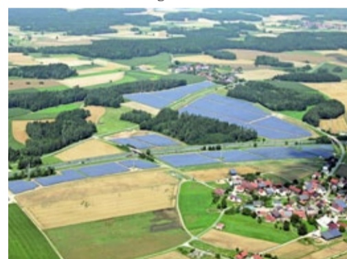
Eines von rund 10 Besichtigungsobjekten am Sonntag, den 13. Juli, wird der Solarpark zwischen Buckendorf und Fesselsdorf sein.
