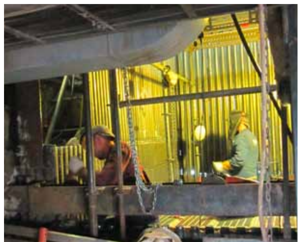
Schweißarbeiten am Müllkessel
