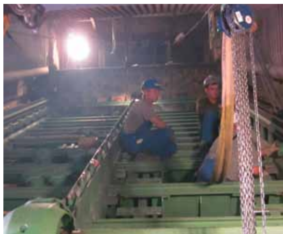
Einbau des neuen Rostrahmens im Müllkessel
