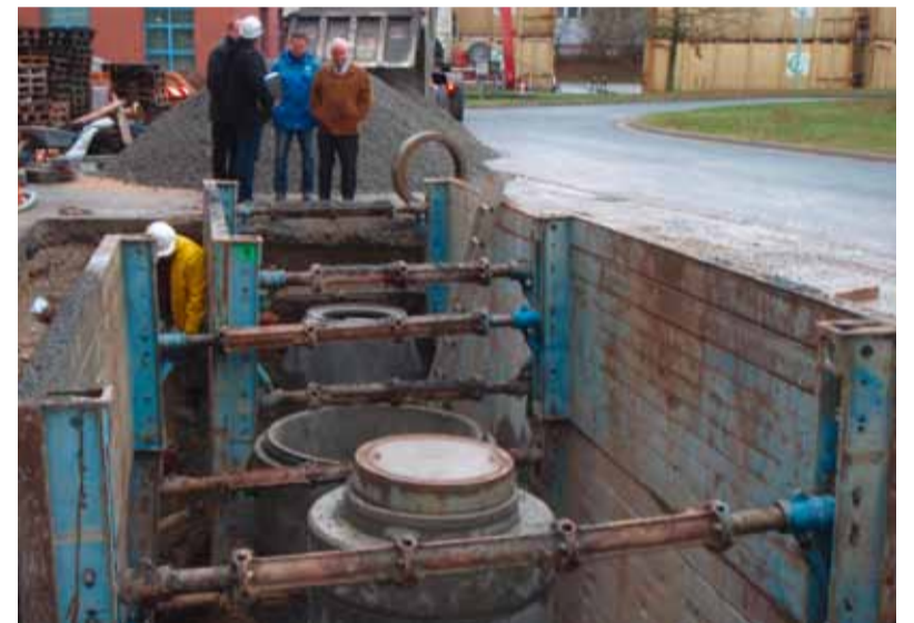
Einige Kanäle auf dem Gelände des MHKW mussten neu gebaut werden.
