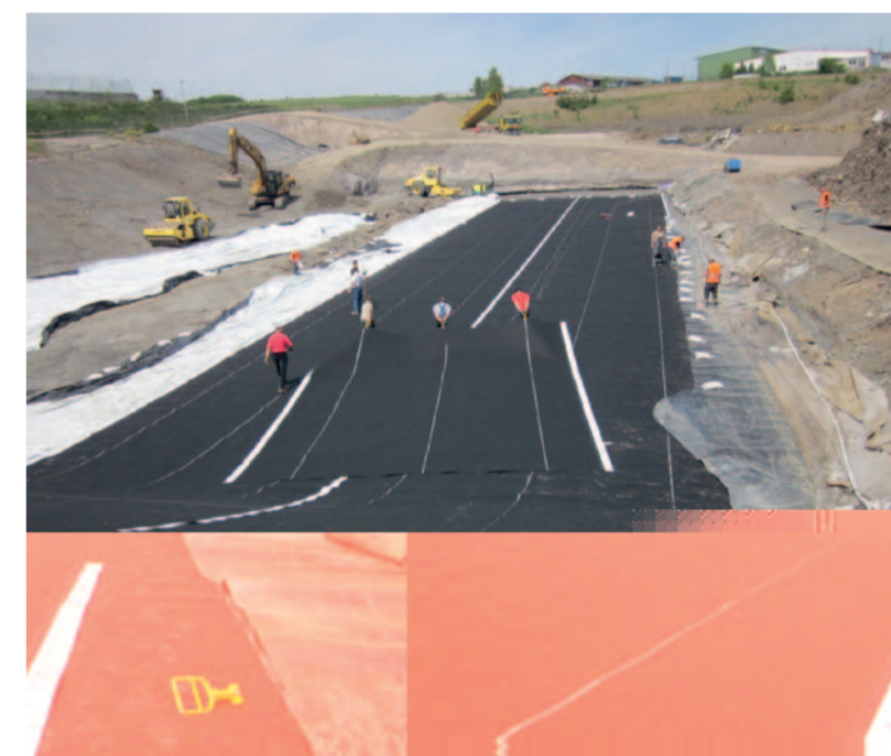
Verlegen der Kunststoffdichtungsbahn im Bauabschnitt BA I
