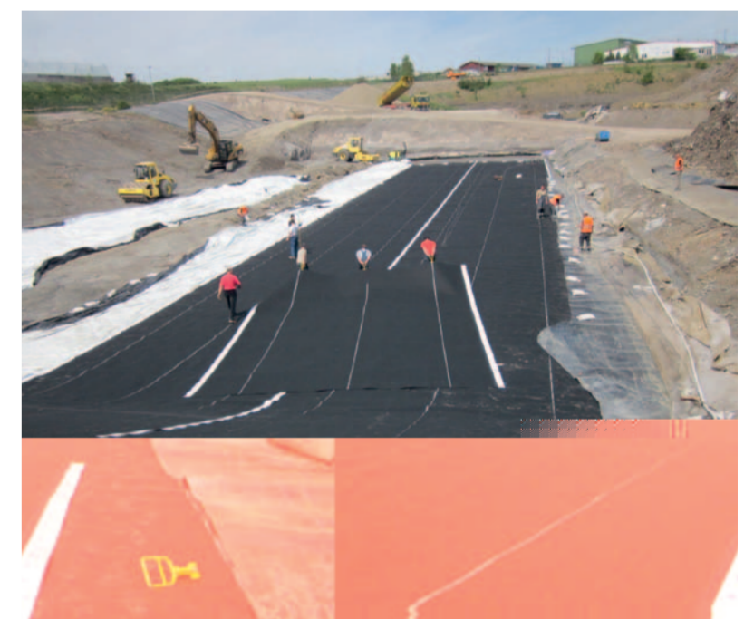
Verlegen der Kunststoffdichtungsbahn im Bauabschnitt BA I
